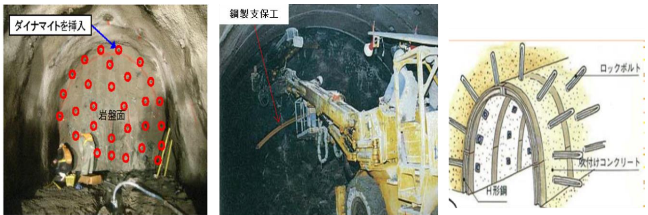
図 2.9：トンネル掘削方法
