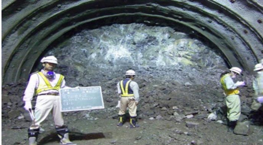
図 2.8：トンネル工事現場での切羽と支保工
