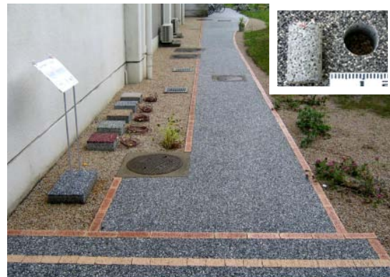
写真-2 施工後の複層ポーラスコンクリート舗装(右上はコア供試体の採取状況)
