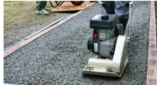
(b) 市販の振動機による締固め状況
