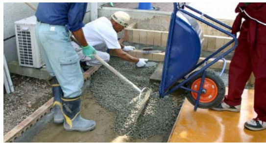
(a) ポーラスコンクリートの打設状況
