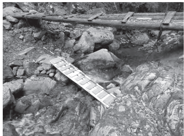
写真1. 黄蓮歩道の改修した架橋。 (上は改修前の架橋)
