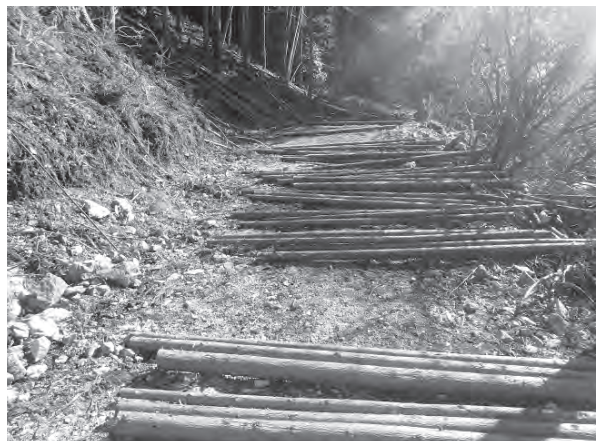
写真1. 新設した作業路まで伐出した小径木の丸太（1林班ろ小班にて）
