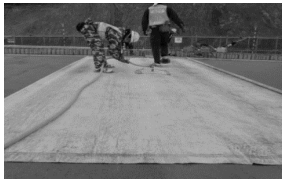
(b) 真空脱水処理の様子
