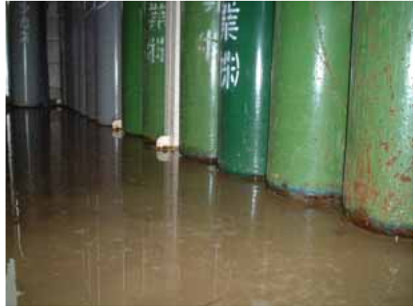
写真2 雨水が溜まっている室内
