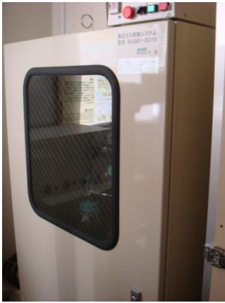
写真5 ガスキャビネットと安全装置
