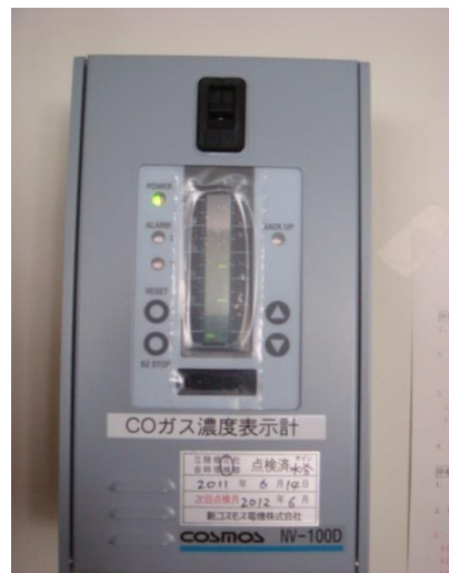
写真4 COガス濃度センサ
