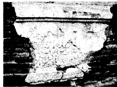
写真8 漆喰内部の塗り継ぎ面
