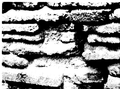
写真5 溶解したように見える煉瓦 (手で触れると砂状になる)
