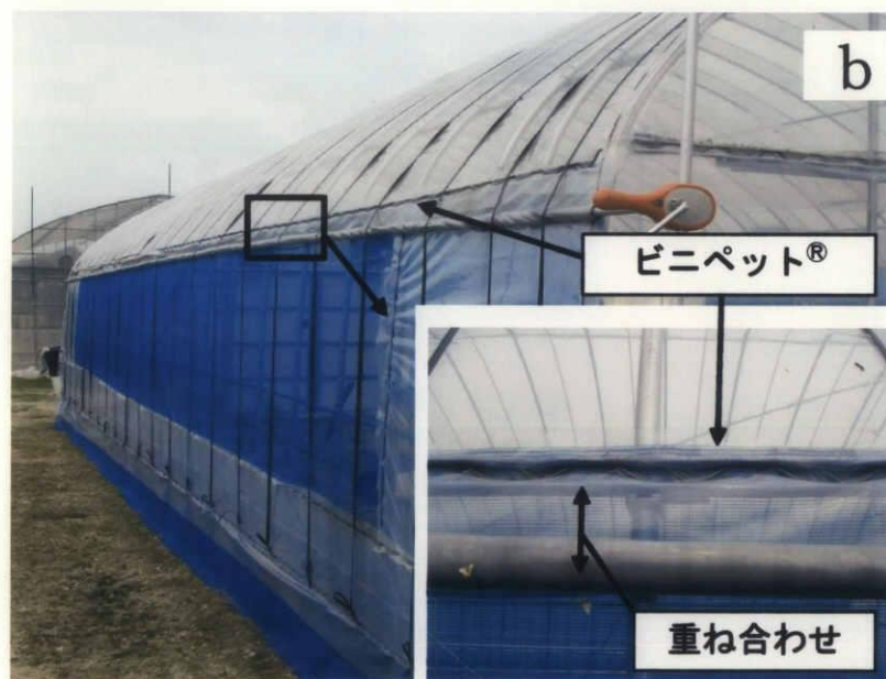
第4図 鉄骨パイプのビニルハウス側窓に施されたネット展張方式 a：パイプ内側パッカー留め方式（セイヨウが隙間にいる）。 b：パイプ外側ビニペット留め方式
