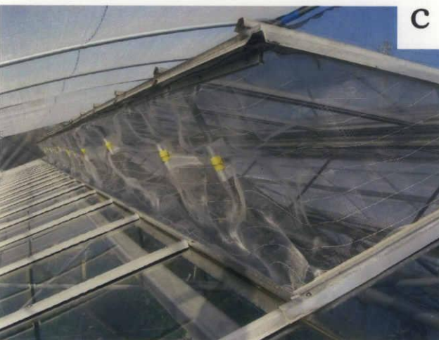
第3図 天窓に施されたネット展張方式
