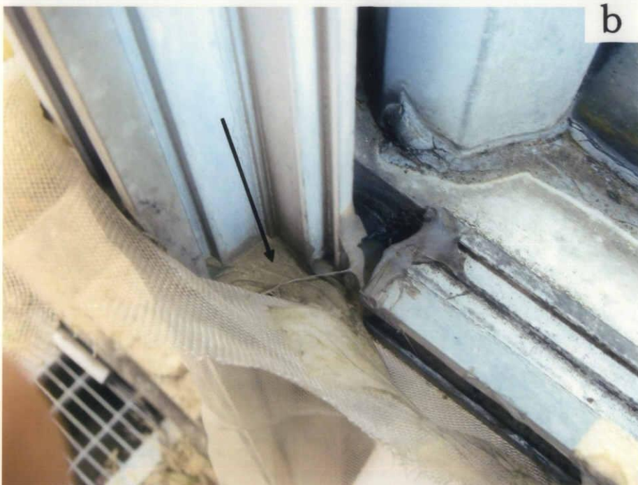
第7図 側窓からの逃亡箇所
