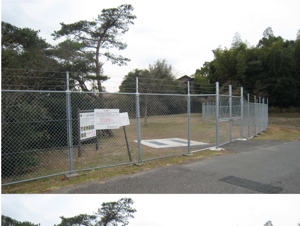
図 1-2-40 対策 3 (防護フェンス) (2011 年 1 月 6 日 筆者撮影)
