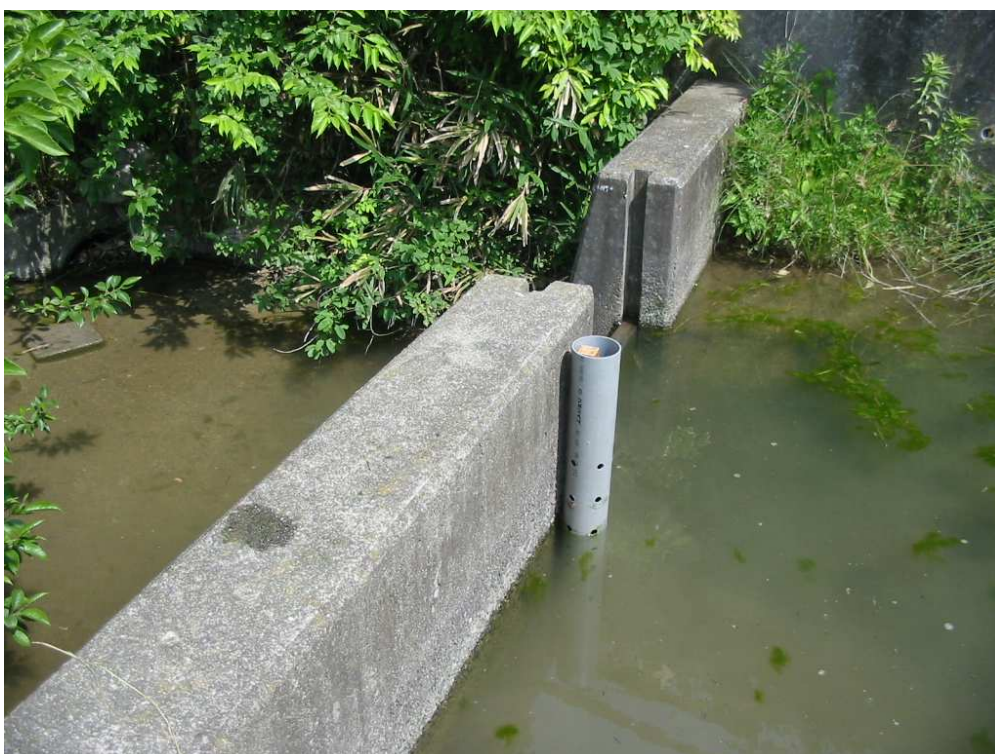
図 3-3-1 沼沢内南西部、四角堰付近測定箇所（水位計データロガー） （2009年8月6日 筆者撮影）
