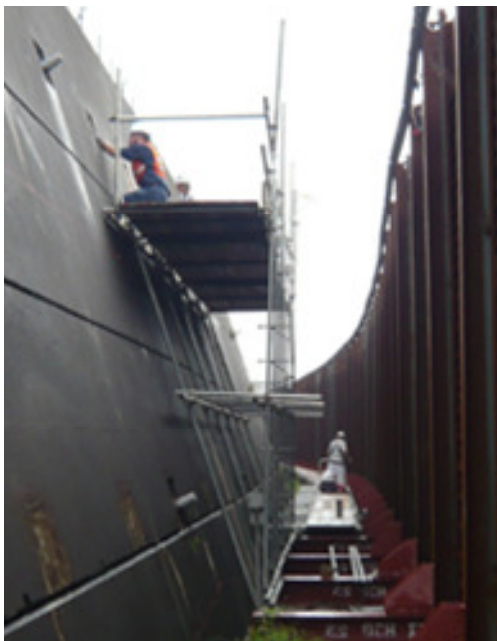
図-3.5 仮設設備の状況
