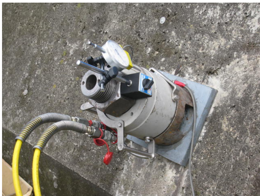
(b) リフトオフ試験の状況
