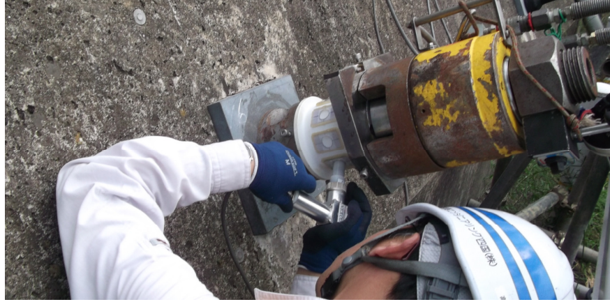
図-4.29 Mリングの設置状況（ナット定着タイプ）
