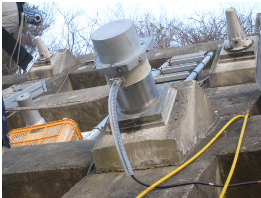
図-4.30 荷重計の計測値のモニタリング（VSL工法）
