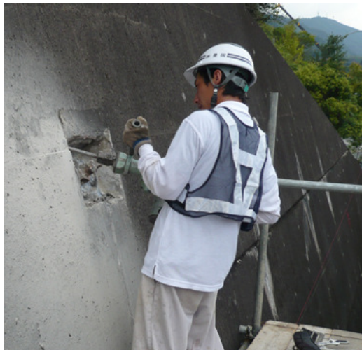
図-3.7 アンカー頭部露出のための擁壁のはつり
