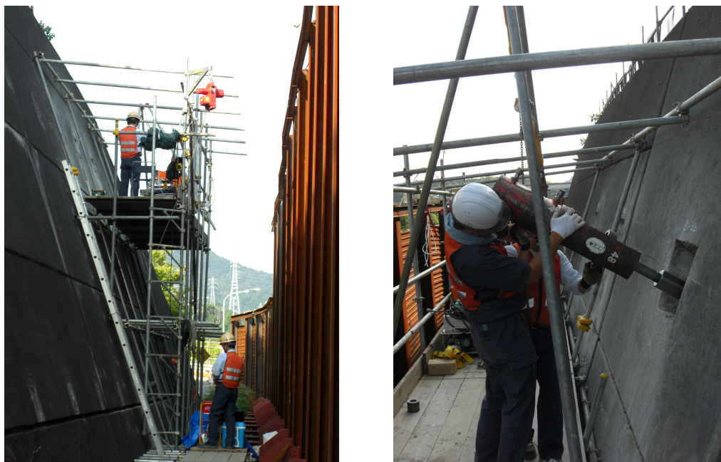
図-1.11 リフトオフ試験の実施状況
