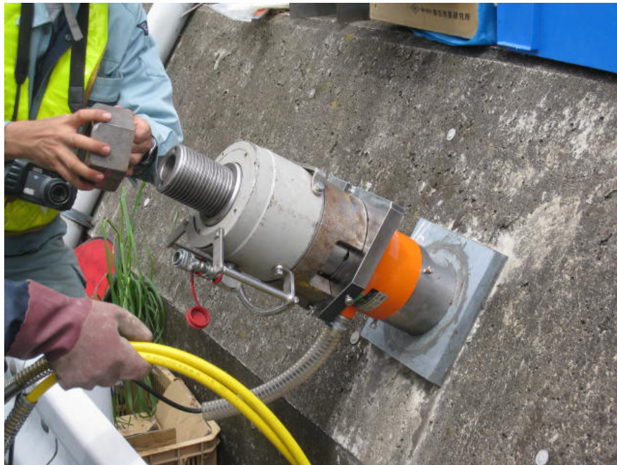
図-4.18 荷重計の設置作業状況
