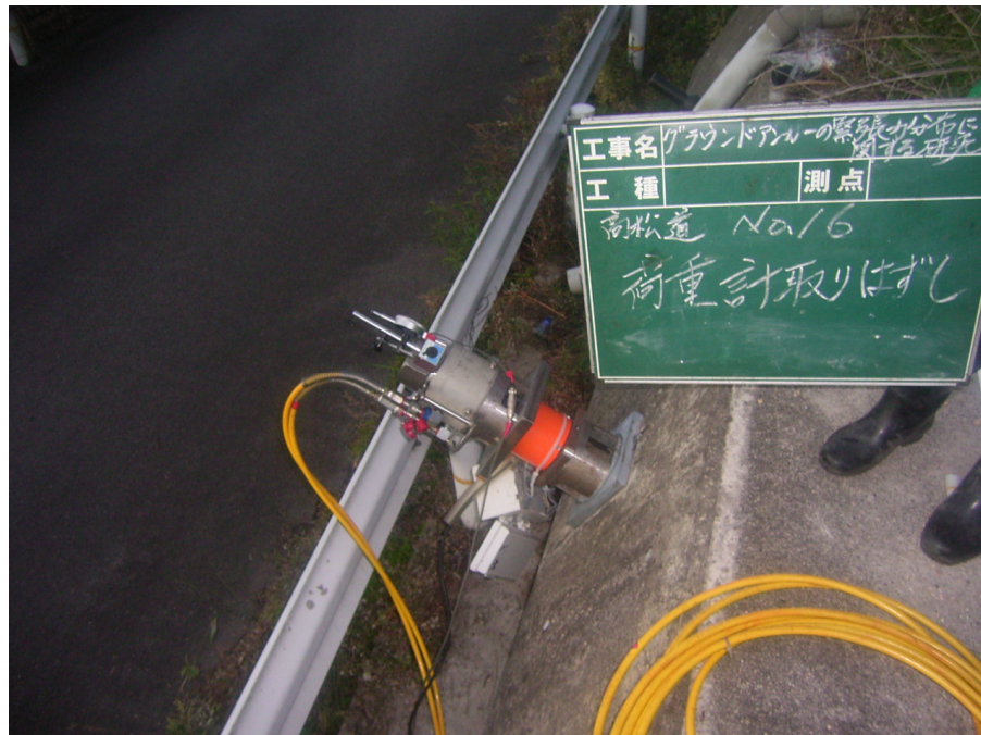
(b) リフトオフ試験の状況
