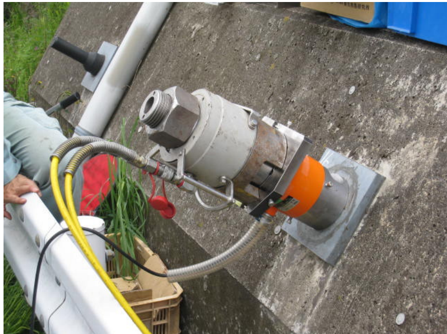
(b) リフトオフ試験の状況
