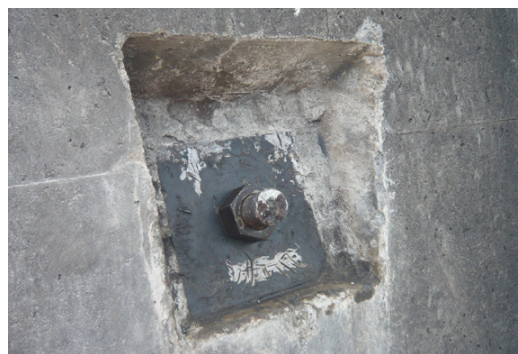
図-3.10 はつり作業により露出させたアンカー頭部 (No.1)
