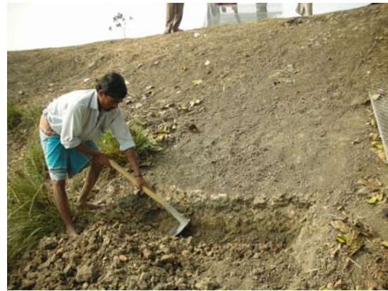
図 6。ゴダガリでの法面保護の実施例
