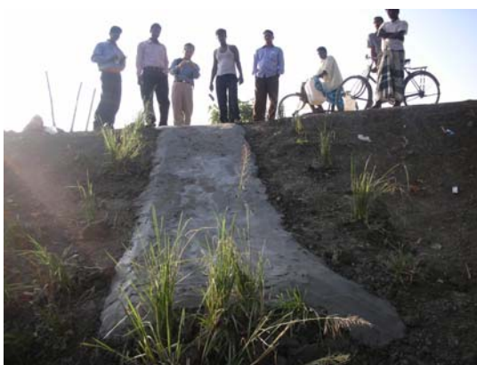
図10。堤防法面保護完了の例
