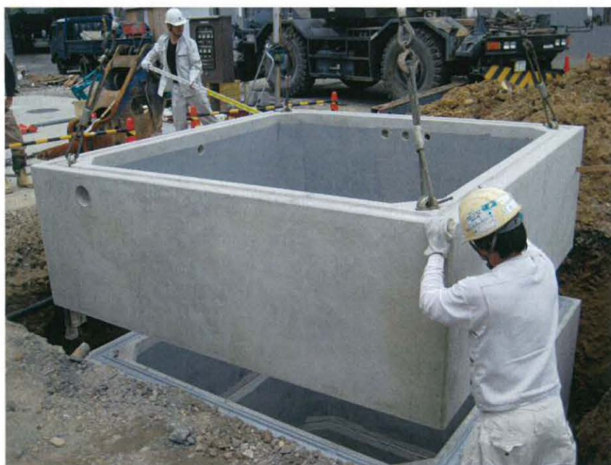
図 5-7. プレキャストコンクリート製水槽 (4) 設置中
