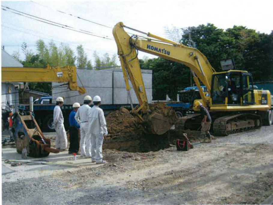
図 5-4. 重機による掘削 (1) 掘削穴の外部状況
