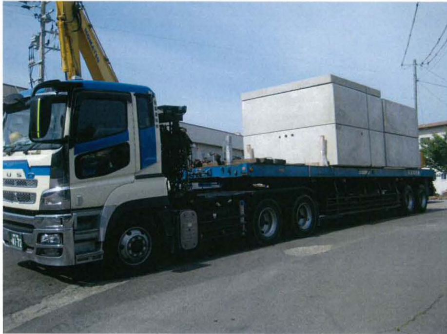
図 5-2. プレキャストコンクリート製水槽 (1) 搬入直後
