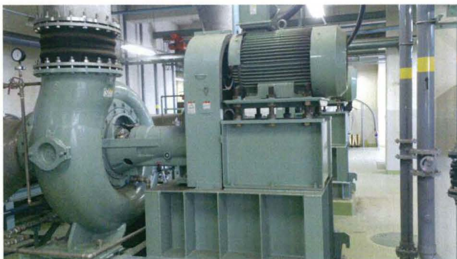
図 1-8. 本研究で用いた硝化脱窒素槽循環ポンプ
