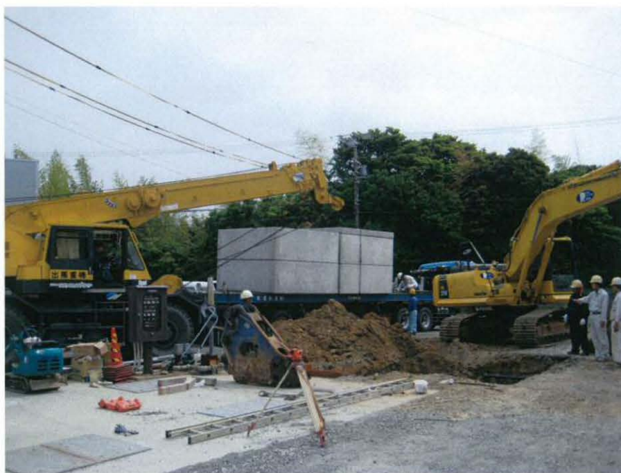
図 5-6. プレキャストコンクリート製水槽 (3) 設置前
