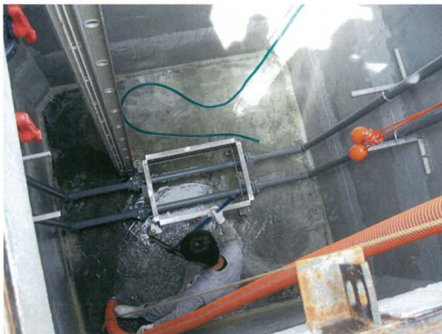
図 5-12. 水平レベル調整後
