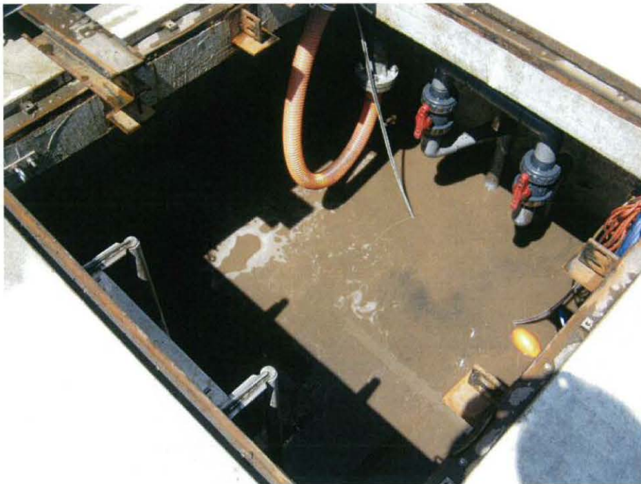
図 3-21. 膜分離槽（水産加工事業所）
