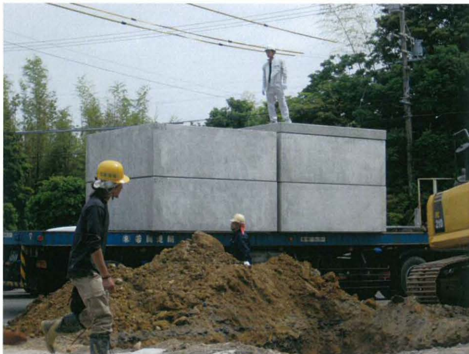
図 5-3. プレキャストコンクリート水槽 (2) 受入検査
