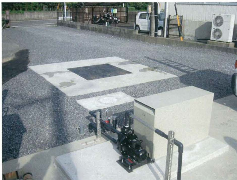
図 5-9. プレキャストコンクリート製水槽 (6) 設置後
