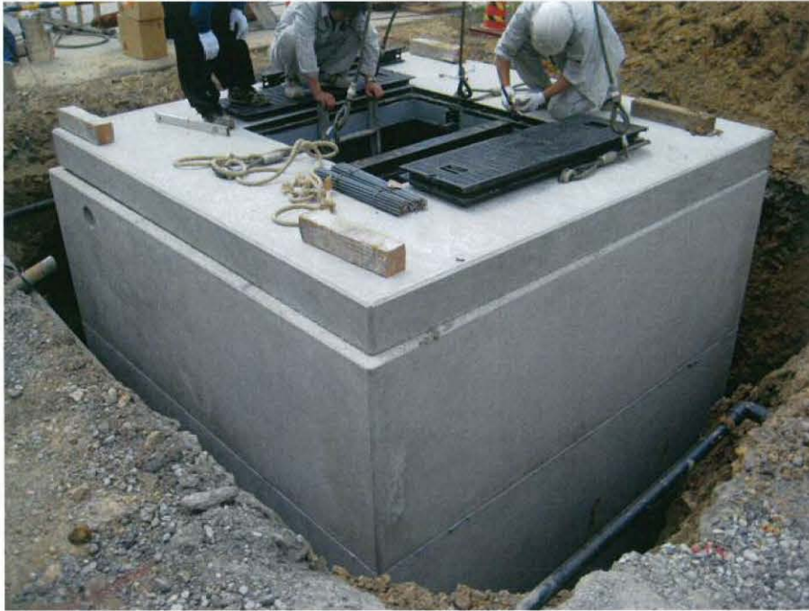
図 5-8. プレキャストコンクリート製水槽 (5) 設置中
