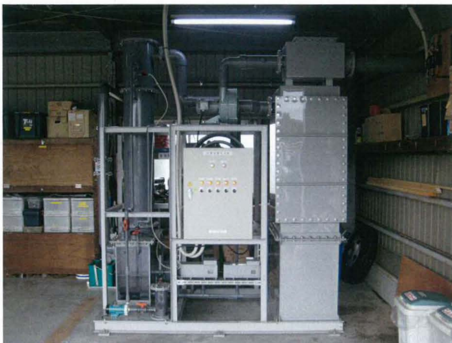
図 3-3. 脱臭設備（スプレー水捕集 + オゾン脱臭）
