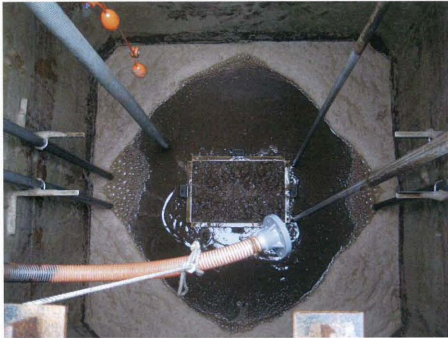
図 5-29. 散気装置の点検（使用 2 年以上）
