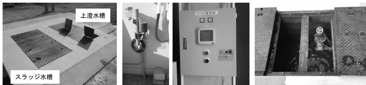
①スラッジ水、上澄水の水槽      ②pH 計      ③pH 計警報盤      ④放流バルブ操作口
