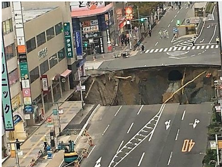
図 5.3 授業で用いた画像：博多駅前の道路陥没の事例
