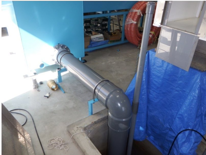
図 18 排水層から地下水槽への導管
