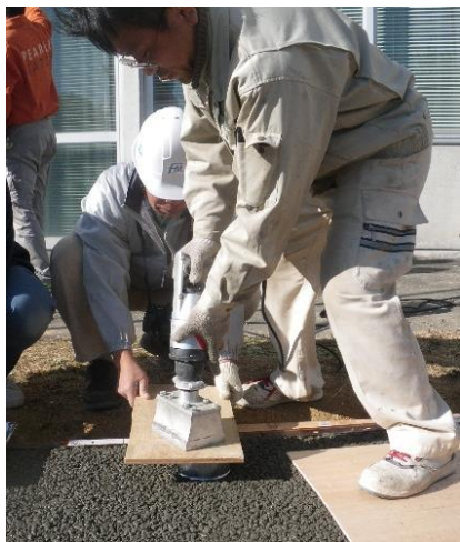
(a) 型枠振動機による鋼管の打ち込み
