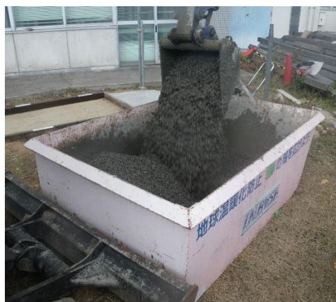
写真 4.3 油圧ショベルによるポーラスコンクリートの練混ぜの様子
