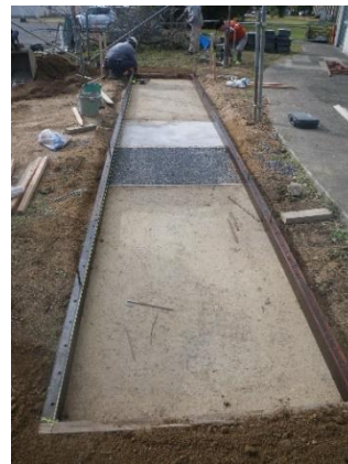
写真 4.2 完成した路床の様子 (手前が No7)
