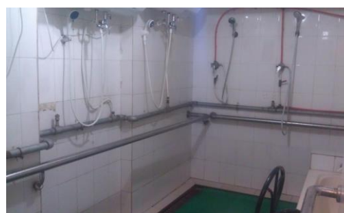
図 2.5.4 シャワー室様子
