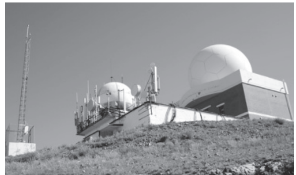
図5 モンゴル・ウランバートルの降水レーダ施設
