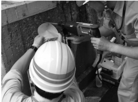
写真-3 ドリルを用いた中性化試験
