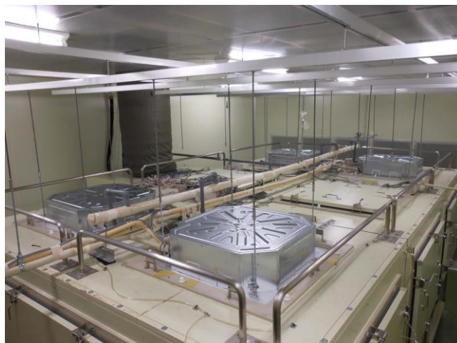
図 2.6 室内機試験状況
