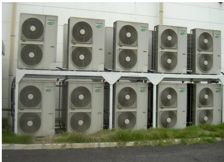
図 3.3 店舗 A におけるパッケージエアコン室外機の設置状況
