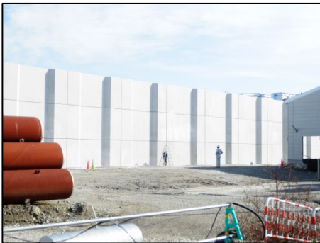
写真 2-11 防潮堤（高さ11m）
