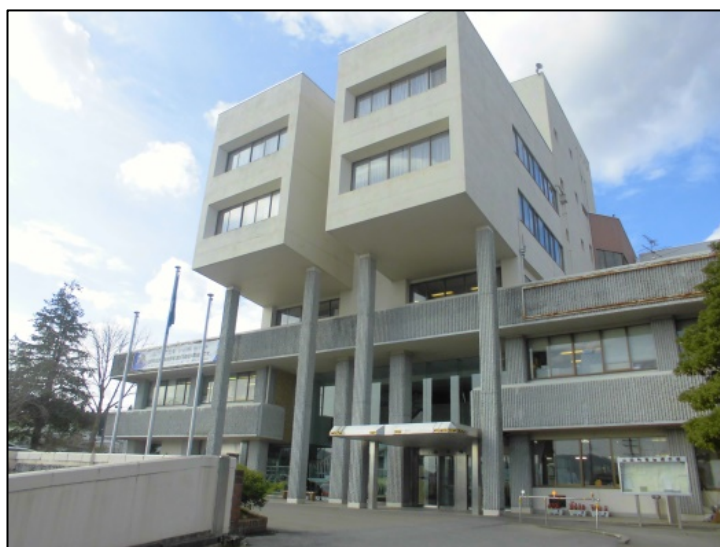
写真 2-2 山田町役場庁舎
