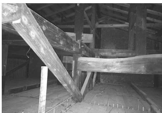
図 2-1 小屋組写真 (現在)
