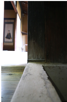
図6-7 痕跡調査(平成26年) 7/11
