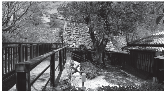
5-3 旧宅正面の石垣上物見台及び階段（平成29年現在）
