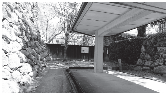
5-4 隠居丸跡北西側の石垣（平成29年現在）
