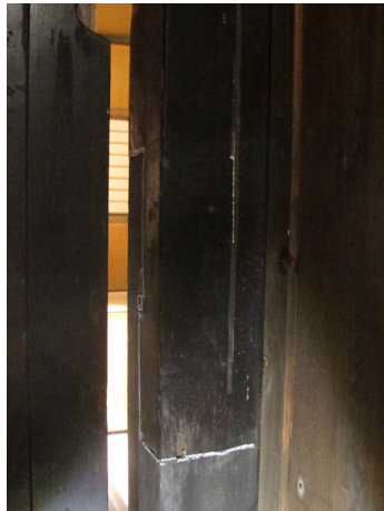
図6-11 痕跡調査(平成26年) 11/11
