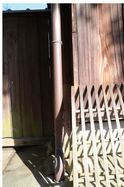
図6-9 痕跡調査(平成26年) 9/11
