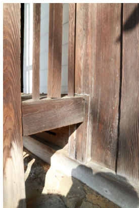
図6-8 痕跡調査(平成26年) 8/11
