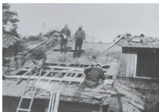
図 4 昭和修理 屋根下地補修の様子 (昭和 41 年)
