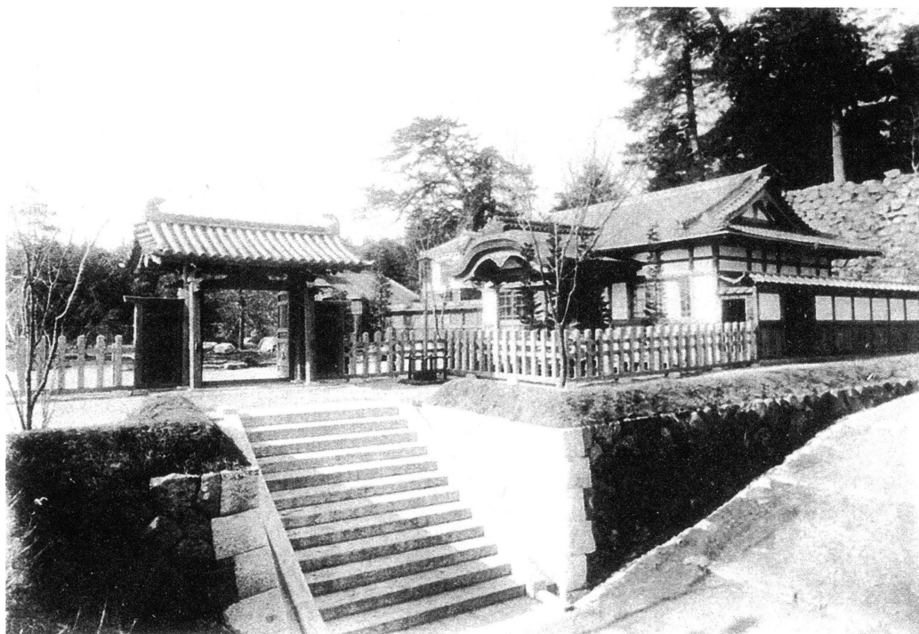
図3 石垣改変 保存会事務所及び表門をみる(明治42年)
