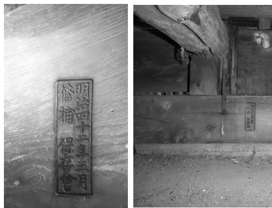
図 3 取替材の焼印 (左: 登合掌材【明治印】 , 右: 土台【昭和印】)
