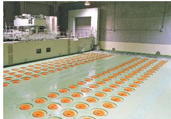
図 35：ガラス固化体の貯蔵施設 (画像提供：日本原燃株式会社)
