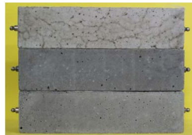
図2-24 表面ひび割れの発生状況の比較 (上からOP, GP1, GP2)
