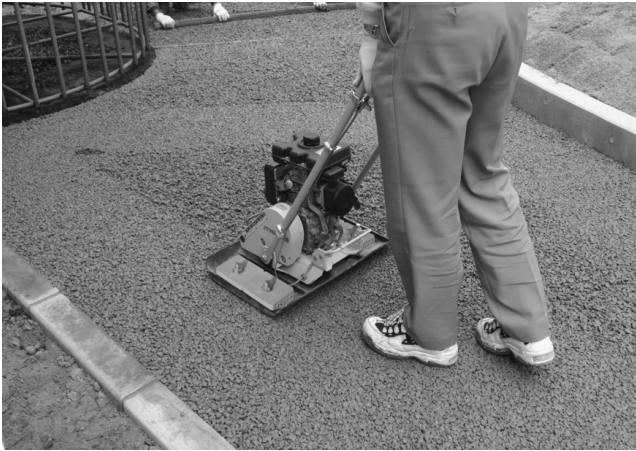
写真-2.1 POC スラブの振動締固め 1)
