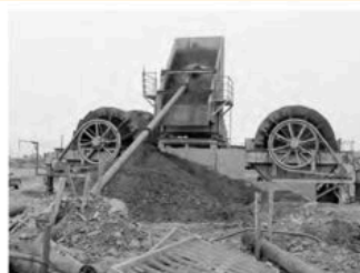
写真18 砂利の選別。吸い上げられた泥水混じりの砂利は、木片などが除かれ、篩い分けられる。
