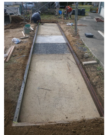
写真-4.3.2 完成した路床の様子 (手前がNo7)
