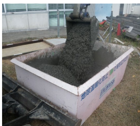
写真-4.3.3 油圧ショベルによる POC の練混ぜの様子
