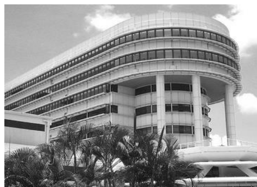
図 3-34 K 病院の外観
