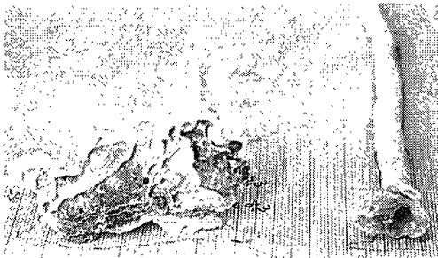
9 Loc. 320 コンクリートつらら基部の空洞と閉窄
