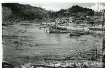
図 5-61 整理番号 61 鳥羽・答志島和具船揚場 魚揚場全景
