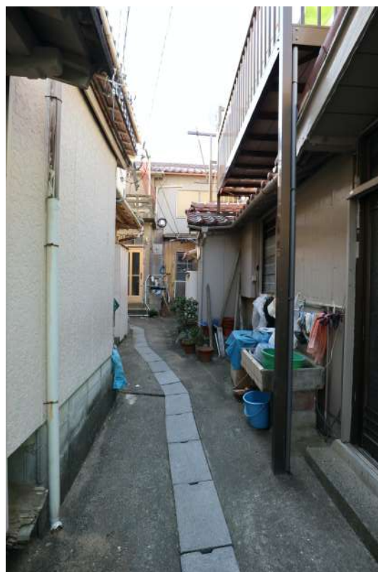
写真 6-3-7-2 追加調査の写真 令和2年
