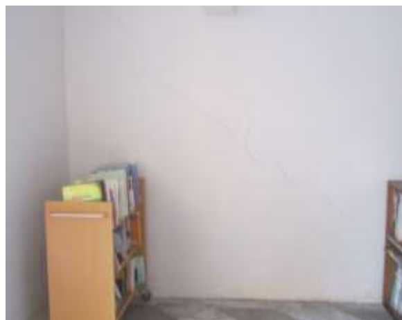
図 2-2-2 壁のせん断ひび割れ
