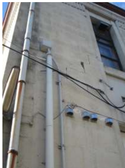
図 5-2-2 外壁ひび割れ
