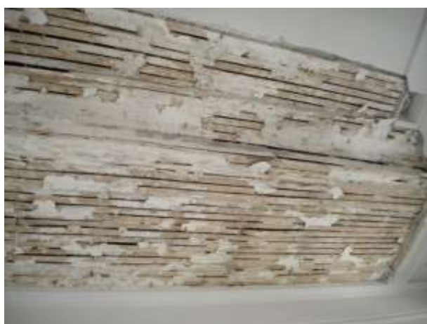
図 2-2-3 天井の漆喰剥落
