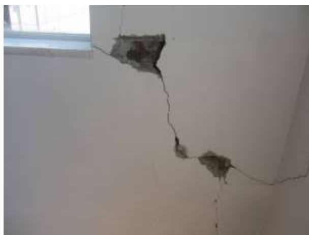
図 2-2-1 開口部周辺のひび割れ
