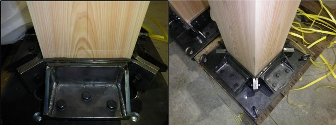
写真 2.2-2 柱脚上部設置型
