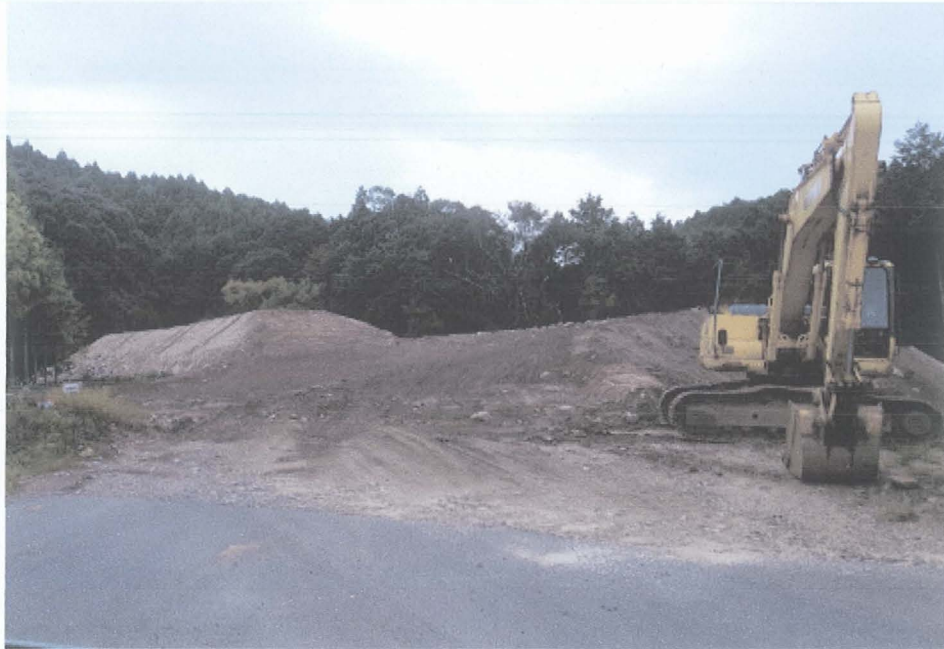
図 2-4 ダム堆砂仮置場
