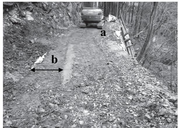
写真2. 東俣木馬道作業道の補修を実施 (a: 崩落部補修, b: 暗渠部拡幅)
