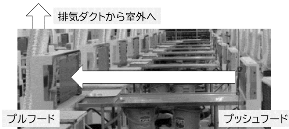
図2 プッシュプル型換気装置を備えた解剖実習室
