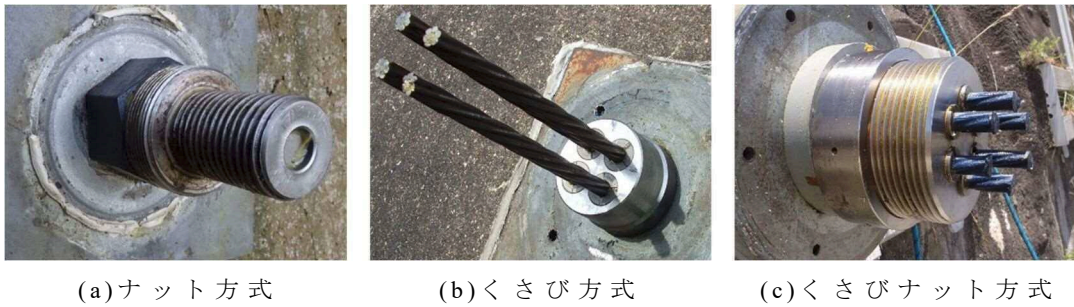
図-1.5 アンカーの主な定着方式 2)
