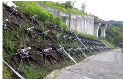
図-1.2 アンカーの施工例
