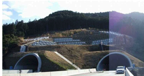
図-1.2 アンカーの施工例
