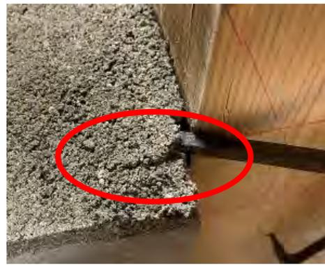
写真 2.5.4 目地モルタルの亀裂
