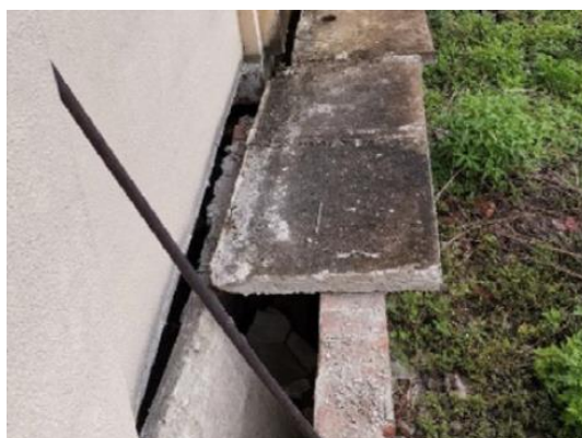
写真 2.17 免震建物(商業ビル)の免震 Exp.J J2-21) [中国 瀘定地震(2022 年 9 月 5 日発生)]
