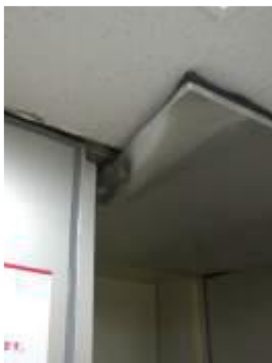
写真 2.9 天井部免震 Exp.J の周辺仕上げ 2-8)
