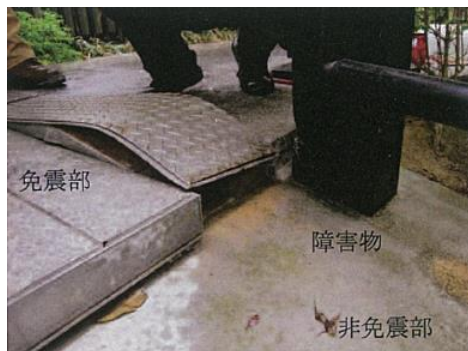
写真 2.11 障害物の設置による損傷 2-16)
