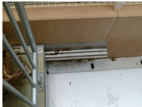
写真 2.12 レール部のゴミ詰まり(損傷なし)
