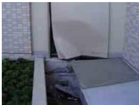
写真 2.6 外構躯体と免震 Exp.J の可動接触による損傷 2-9)
