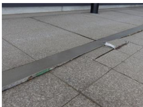
写真 2.8 免震 Exp.J の周辺仕上げとの損傷(その 2) 2-12)
