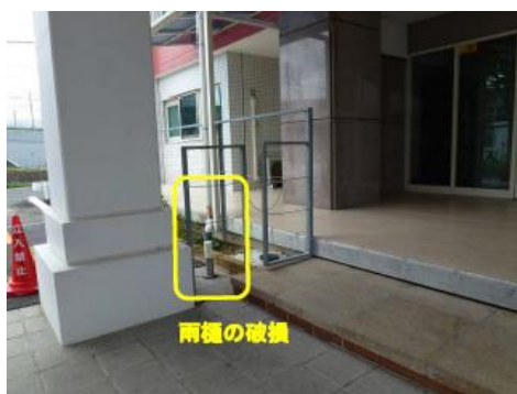
写真 2.10 雨樋と免震 Exp.J の接触 2-10)
