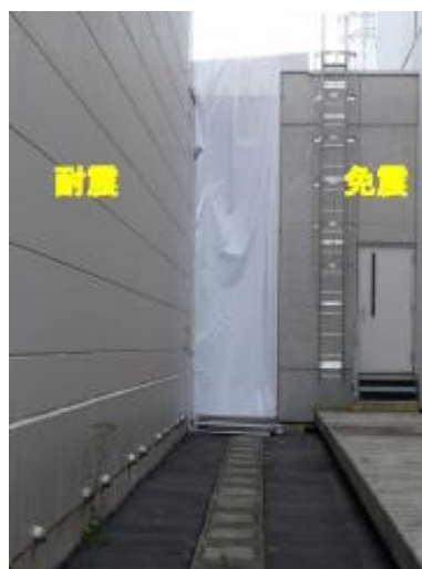
写真 2.4 壁部免震 Exp.J の損傷 2-10)
