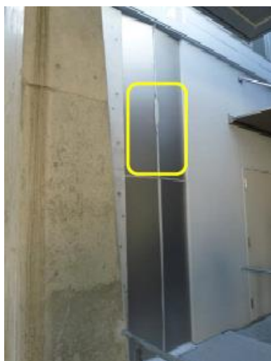
写真 2.3 壁部免震 Exp.J の残留変形 2-10)
