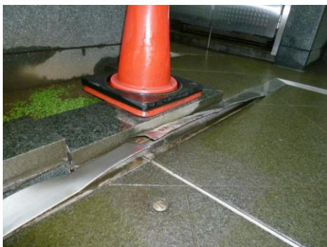
写真 2.5 床部免震 Exp.J の先端部の損傷
