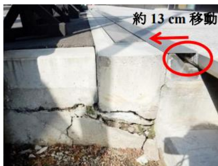
写真 2.18 免震 Exp.J 可動による外構躯体の損傷 2-25)
