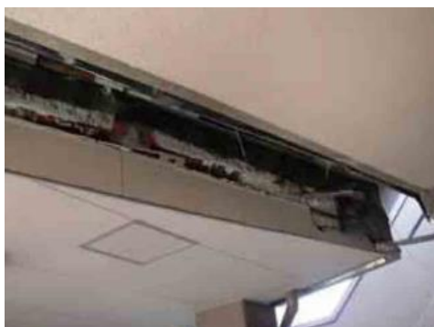
写真 2.1 渡り廊下軒天の損傷 2-9)
