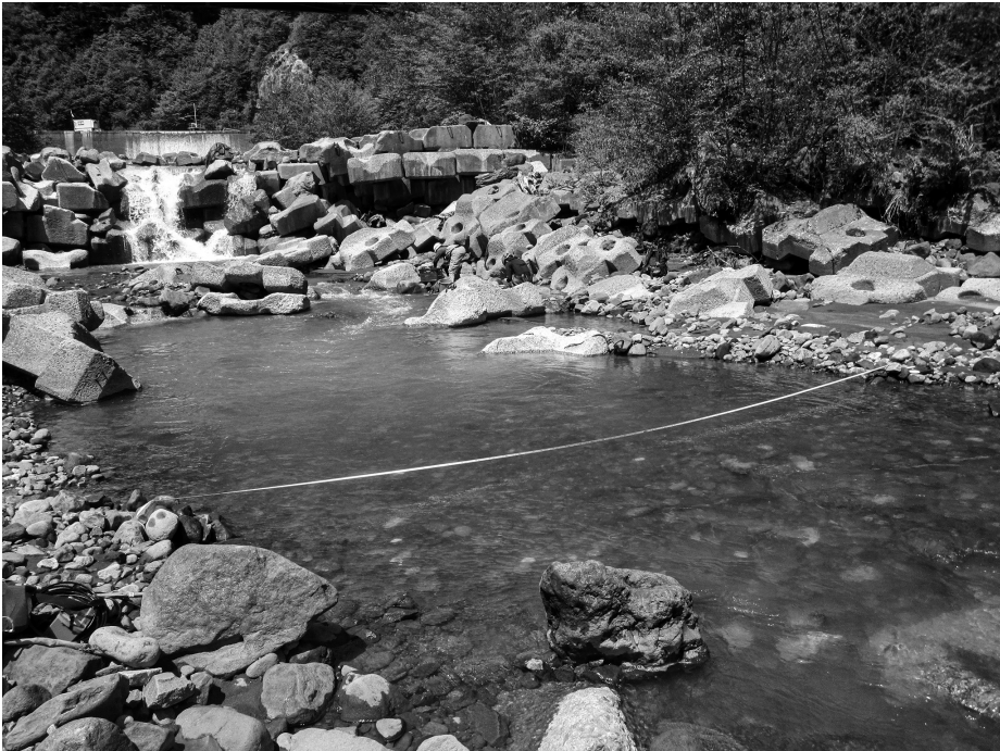
写真2 濁川柳ヶ瀬 (地点①) (2022年5月28日谷口撮影)
