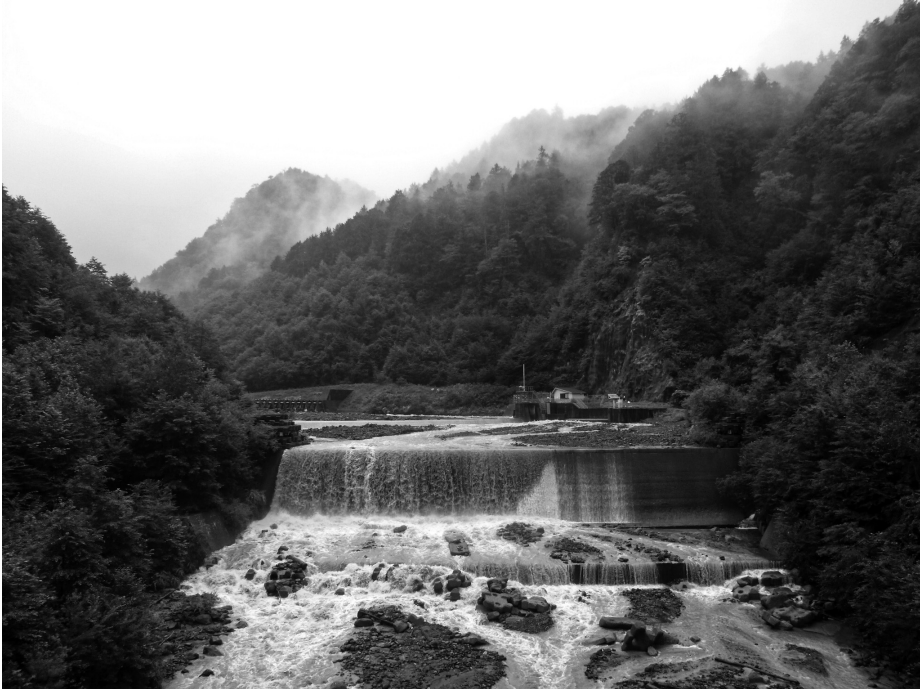
写真1 濁川の発電用河川取水施設 (2015年9月6日谷口撮影)
