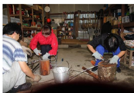
図6 ワイヤースリング作製
