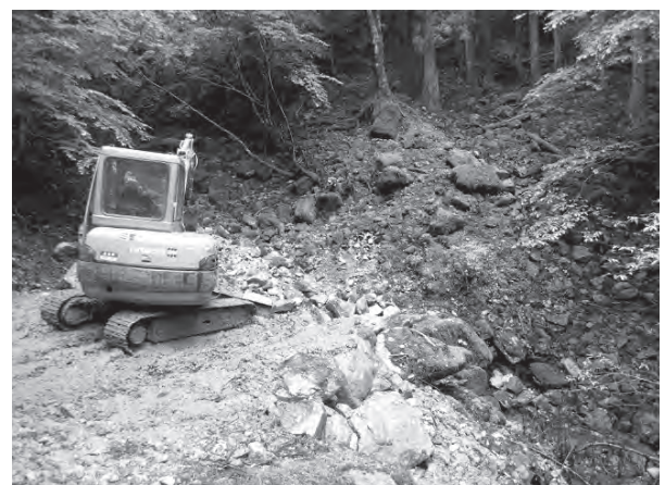
写真2. 昨年度から引き続き作業道開設を実施。（ぬたの谷を「洗い越し」で渡す作業中）。
