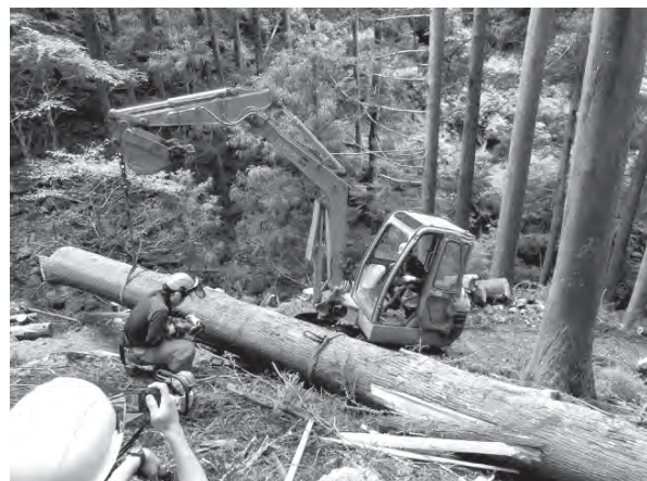
写真1. 作業道開設の支障木を伐倒後に玉切り。
