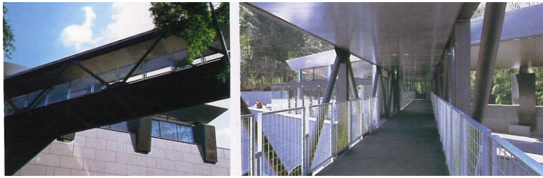
図 3.2.33 笠間日度美術館東館 北立面図、東館屋上から西館側へブリッジの写真
