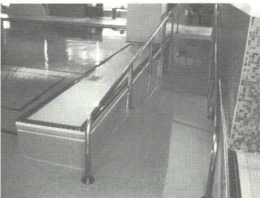
図7 水中のスロープ(右側)
