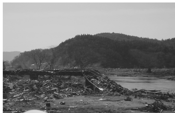
崩壊した線路
