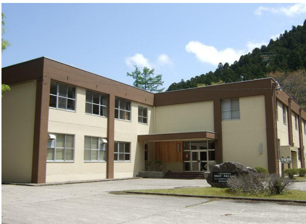
図 1. 演習林管理棟・宿泊棟
