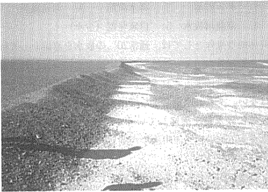
Photo VI-6 白楊河からの洪水流をゴビに湛水貯溜するためのプルによる掻上げ堤防 (トクスン県河東郷上流)
