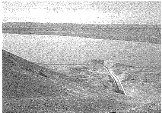
Photo VI-7 紅山ダム (トクスン県) 右下の流れは白楊河右岸に取水する灌漑導水路からの分水
