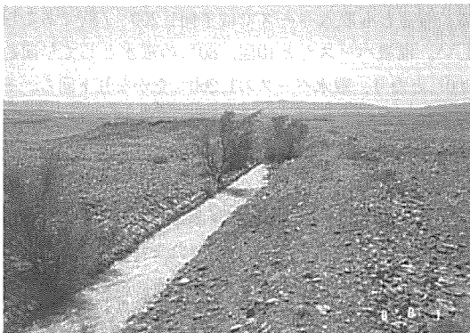
Photo IV-4 雪解け導水路 五道林カレーズ上流附近の塔爾朗渠分線
