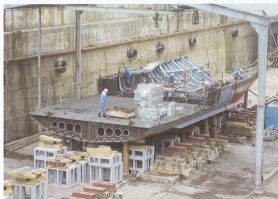
写真8 ドックにタンクトップを据え付けたところ
