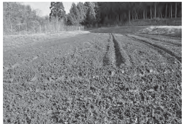
図8 暗渠工事後埋め戻し
