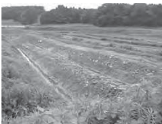
図2 暗渠用仮排水路素堀
