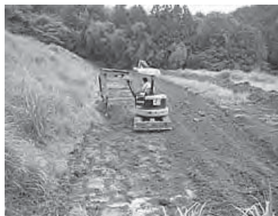
図4 暗渠排水の埋め戻し
