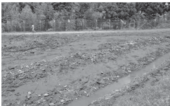
図6 仮排水路の設置
