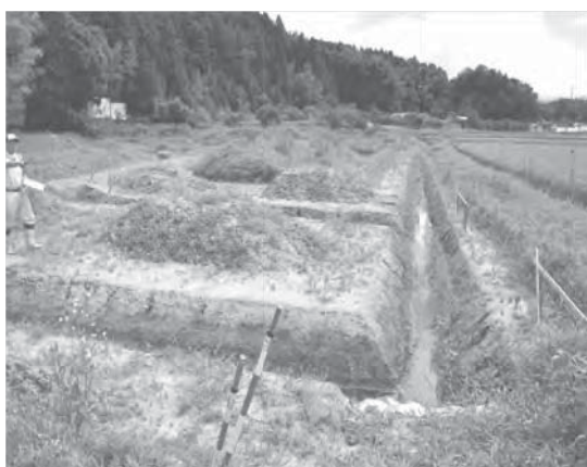
図3 湿田土壌が仮排水路により固化した状態
