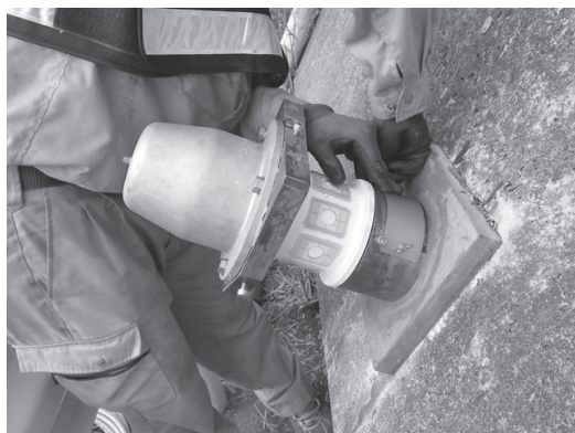
図-8 Mリングの設置状況
